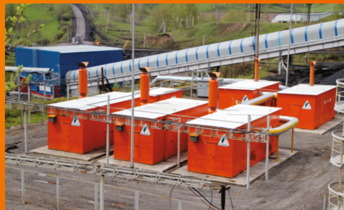
ЗАО «Шахтоуправление «Талдинское-Южное», строительство объекта «Передвижная наземная вакуум-насосная станция на промплощадке ЗАО «Шахтоуправление «Талдинское -Южное»
