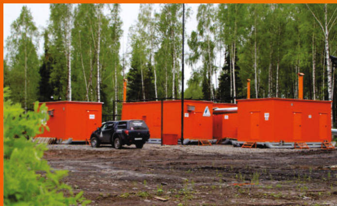
ОАО «ОУК «Южкузбассуголь», ООО Шахта «Усковская», монтаж дегазационной установки МДУ-110RB и поверхностного дегазационного трубопровода L=2000м
