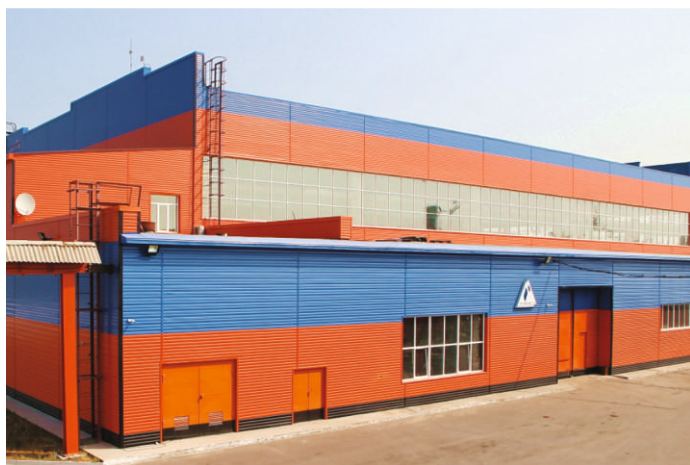
ООО «НПП «Завод МДУ» , реконструкция АБК
