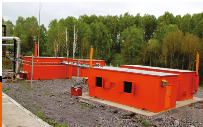
ОАО «ОУК «Южкузбассуголь», строительство объекта «Передвижная наземная вакуум-насосная станция на промплощадке грузового наклонного ствола» филиала «Шахта «Юбилейная» 2 район.
