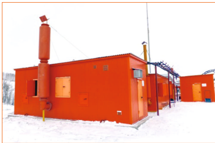
ЗАО «Сибуглемет», ОАО «Шахта «Антоновская» , строительство объекта «Передвижная наземная вакуум-насосная станция на промплощадке ОАО «Шахта «Антоновская».
