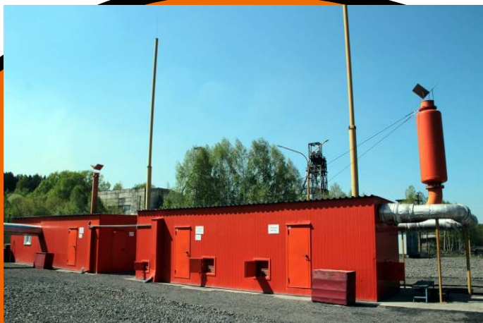
ЗАО «ТопПром», ООО Шахта «Юбилейная» , строительство дегазационного комплекса на промышленной площадке вертикального ствола № 5.
