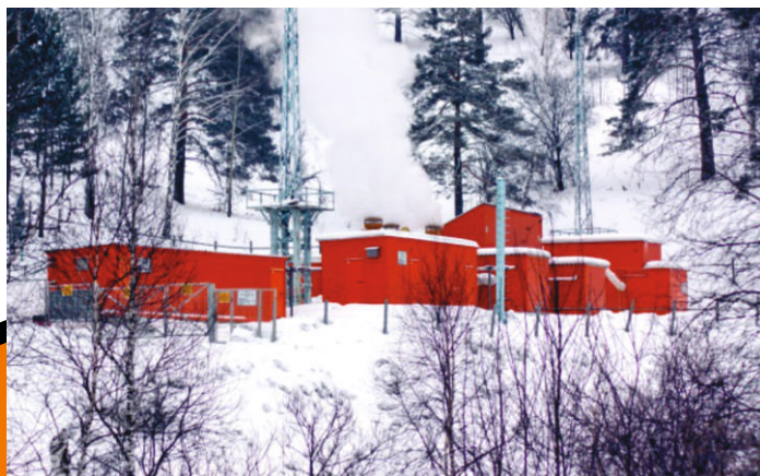
ЗАО «Сибуглемет», ОАО «Шахта «Большевик», монтаж МДУ и устройство водоснабжения и водоотведения поверхностной дегазационной станции.
