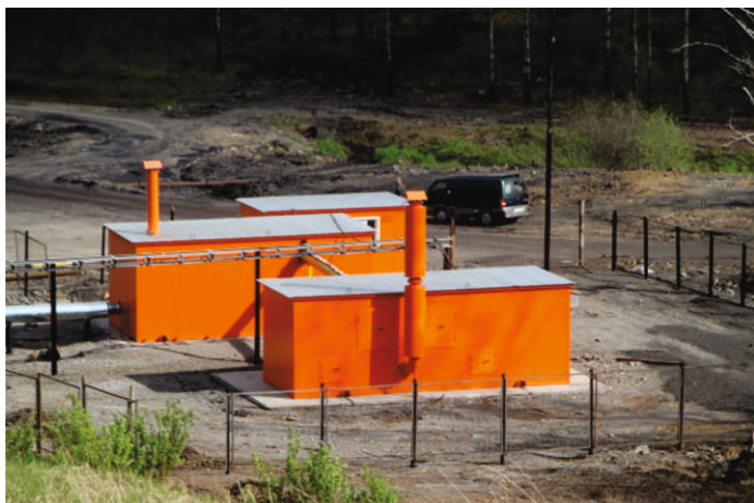
ЗАО «Шахтоуправление «Талдинское-Южное» , строительство объекта «Передвижная наземная вакуум-насосная станция на промплощадке ЗАО «Шахтоуправление «Талдинское-Южное».
