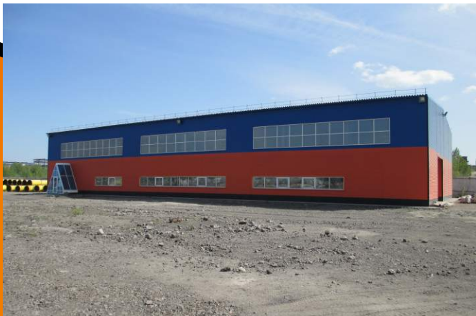
ООО «НПП «Завод МДУ» , строительство цеха №2
