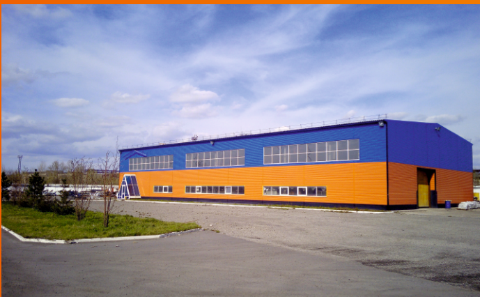
ООО «НПП «Завод МДУ», строительство цеха №2
