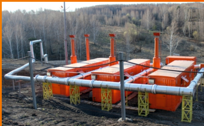
ЗАО «ТопПром», ООО Шахта «Юбилейная», выполнены строительно-монтажные работы, установка МДУ-540RBS
