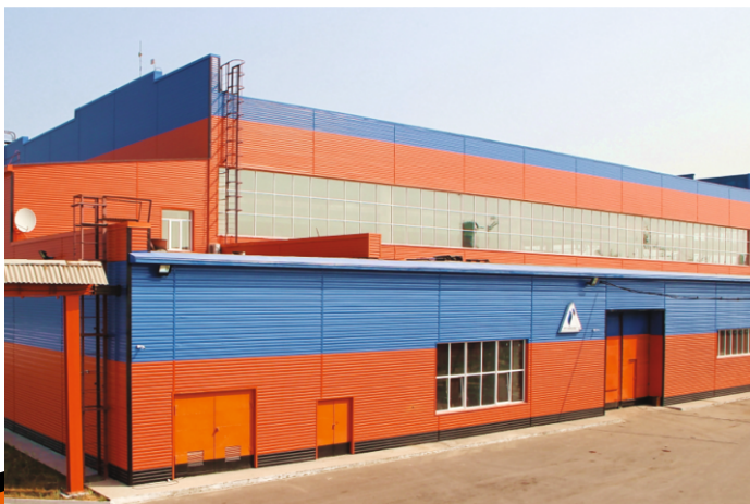
ООО «НПП «Завод МДУ», реконструкция АБК
