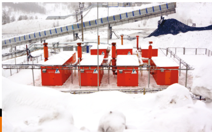
ЗАО «ШУ «Талдинское-Южное», строительство объекта «Передвижная наземная вакуум-насосная станция»
