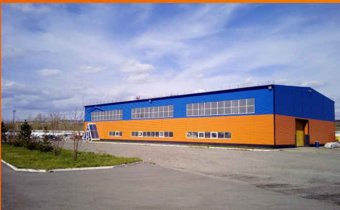
ООО «НПП «Завод МДУ», строительство цеха №2
