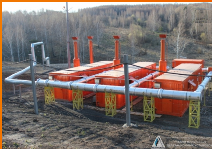
ЗАО «ТопПром», ООО Шахта «Юбилейная», выполнены строительно-монтажные работы, установка МДУ-540RBS
